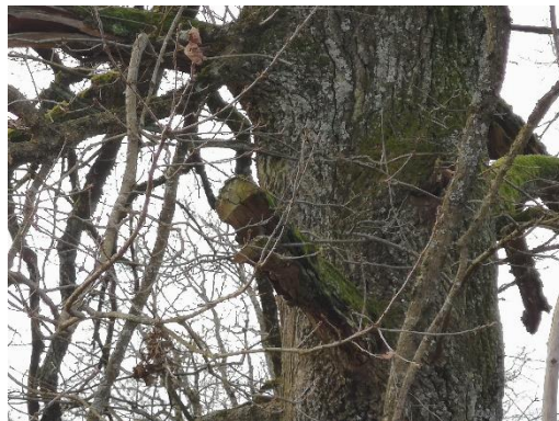
Abbildung 19: Astabbruch an der Eiche
