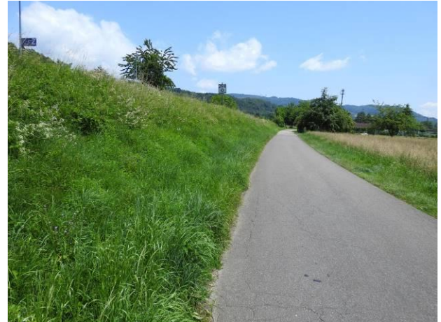
Abbildung 23: Böschungsbereich (außerhalb PG) an der Bahnstrecke im Teilbereich Fischmatt (Foto: Kunz GaLaPlan)
